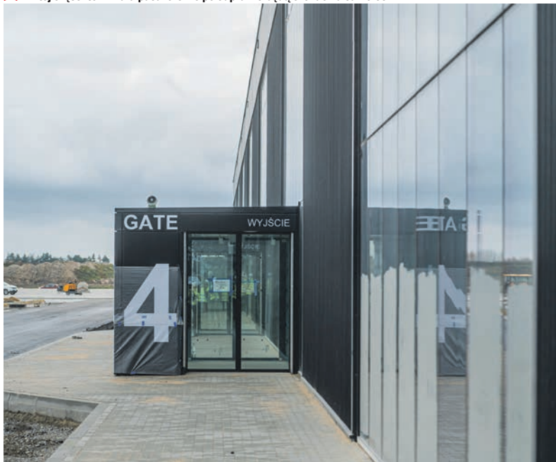
Bramek wyjściowych zaplanowano kilka
